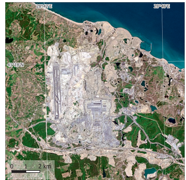
5. Baustelle des neuen Istanbul Flughafens. Das Echtfarben-Satellitenbild veranschaulicht, wie massiv der Eingriff der Bauarbeiten in die Landschaft ist. Daten: Sentinel-2, 24.07.2017.
