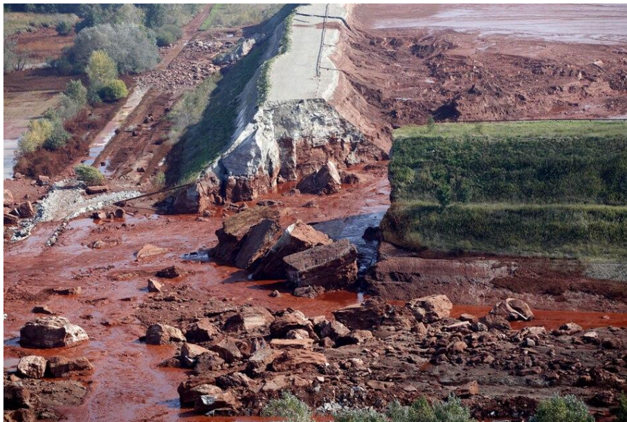
Ansicht des Damms und des Rotschlammes nach dem Bruch (Foto: Kormányzati Kommunikációért Felelős Államtitkárság)
