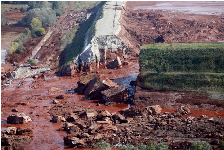
Vue du mur et de la boue rouge après la rupture (photographie : Kormányzati Kommunikációért Felelős Államtitkárság)
