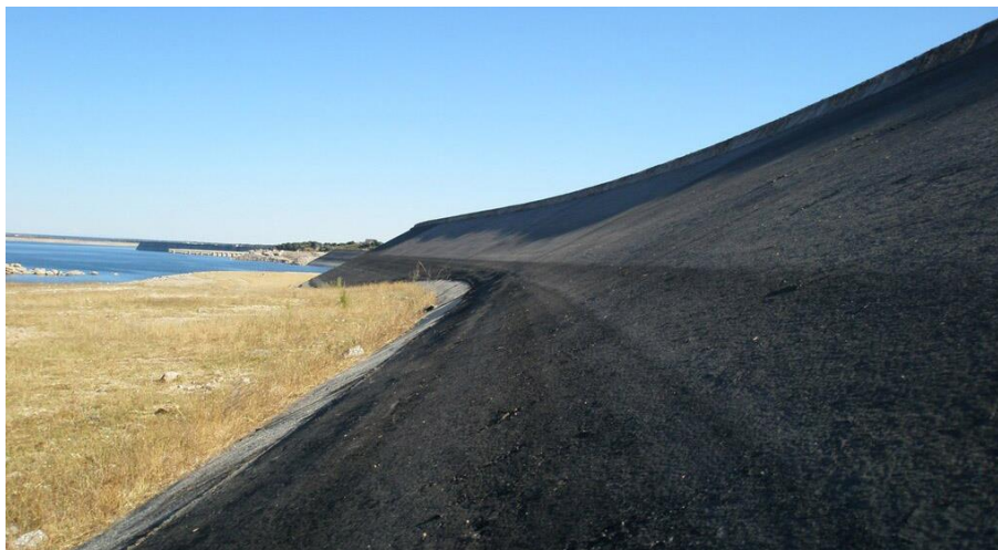
Vue du barrage montrant le faible niveau d'eau (photographie : Perronaider)
