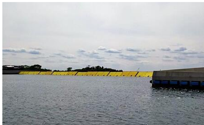
Vue du système MOSE en fonctionnement (photo : Sandro Fusi)
