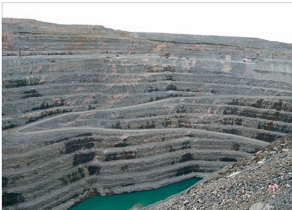
3. Vista della struttura a terrazze della miniera a cielo aperto di Aitik.
